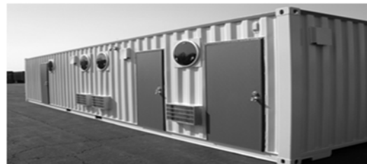
Рис. 4. Дизельний електрогенератор контейнерного типу
